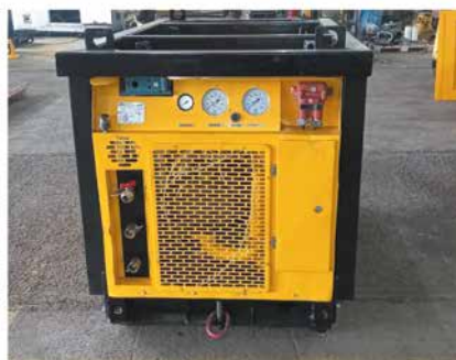
Капитальный ремонт подземного компрессора
